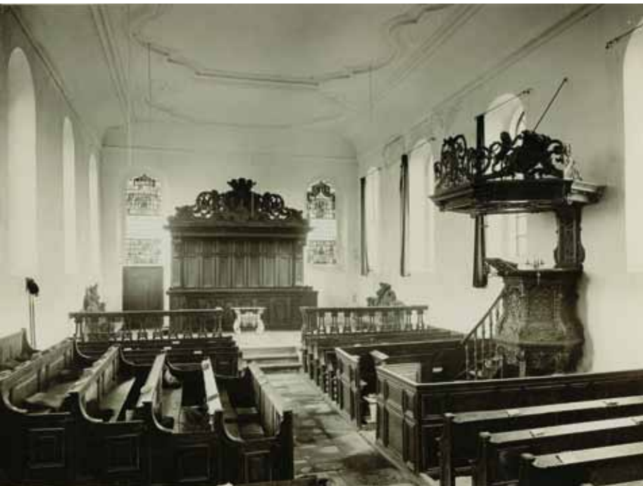
De voormalige ziekenzaal van de abdij van Aduard, voor de restauratie (foto 1910).
